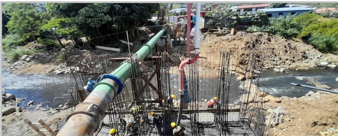
Construcción puente sobre el río Cañas
