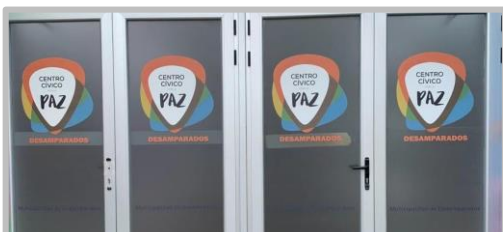
Instalación de sandblasting en puertas principales
