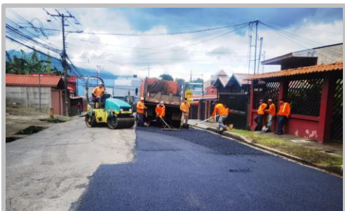
Asfaltado Gravilias, Villa Nueva
