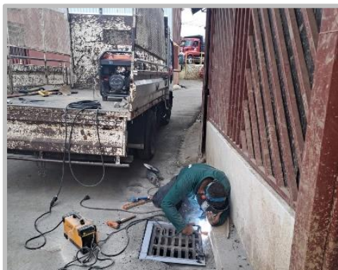
San Rafael Abajo Colocación Parrilla
