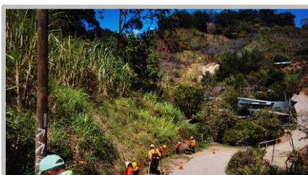
Calle Méndez, Canalización
