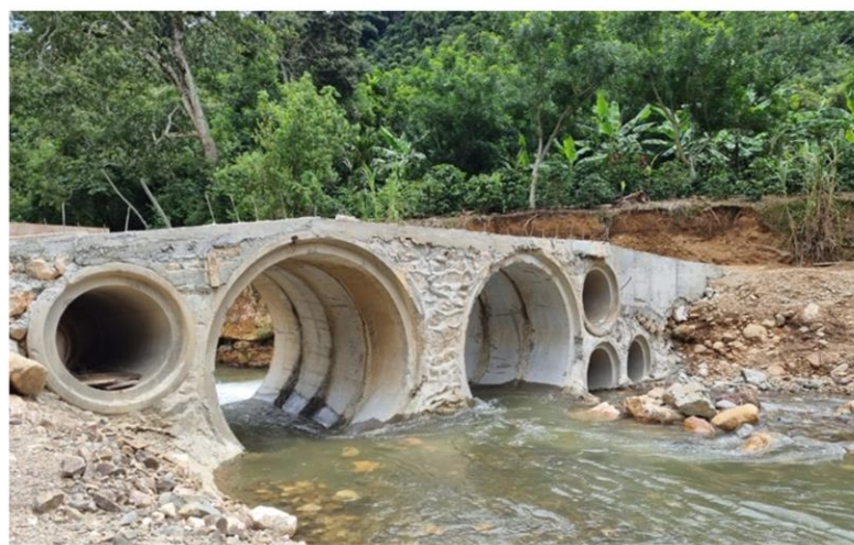
Frailas, reconstrucción del paso vehicular en Bajo Los Ángeles.
